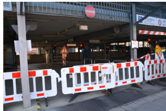
Das aus Sicherheitsgründen gesperrte P+R-Parkhaus.
