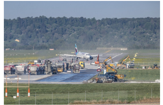
Generalsanierung der Start- und Landebahn des Flughafens.
