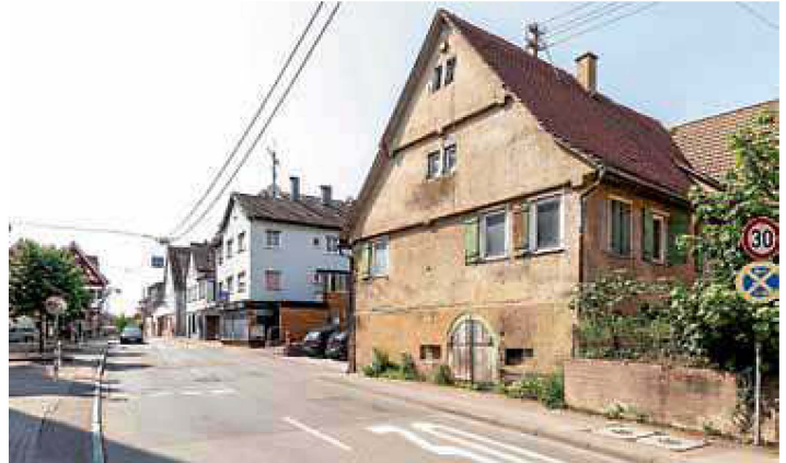
Die Uhlbergstraße in Plattenhardt soll Teil eines Sanierungsgebietes werden.
