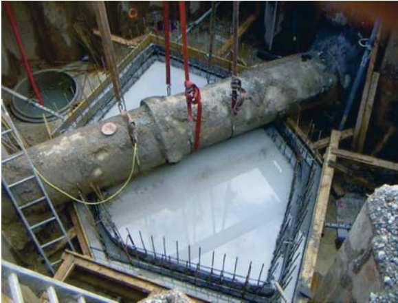
Bau eines Schachtes unterhalb einer Bestandsleitung im Februar 2013, Foto: Weber Ingenieure GmbH
