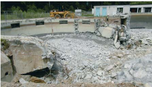
Abbruch des alten Nachklärbeckens im Juli 2013, Foto: Weber Ingenieure GmbH
