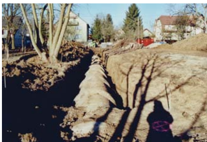
Rohr freigelegt, Foto: Margit Riedinger
