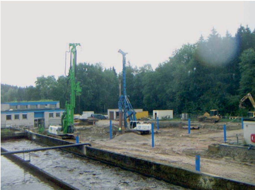
Herstellung der Entspannungsbrunnen und des Spundwandverbau im September 2013, Foto: Weber Ingenieure GmbH
