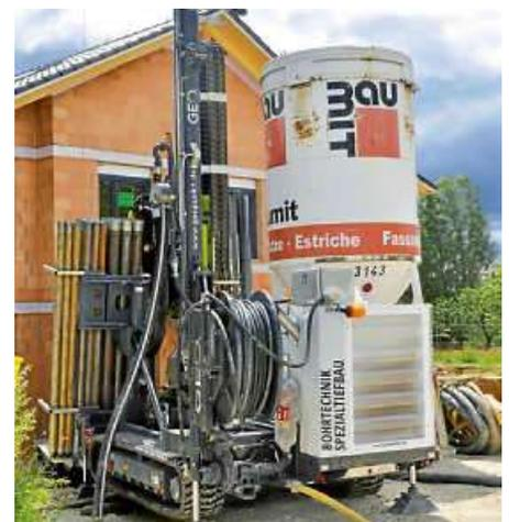
Bei dieser Erdwärmeebohrung in Plattenhardt werden Wärmesonden bis etwa 100 Meter Tiefe eingebracht.
